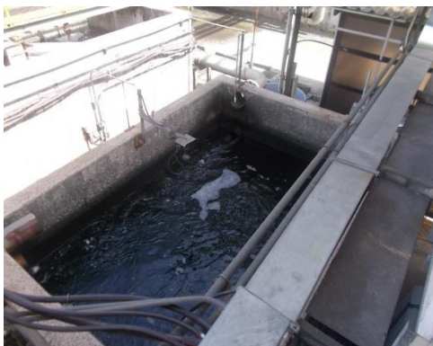
รูปที่ 3-16 Chlorination System
