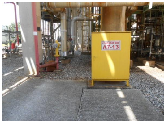
รูปที่ 3-48 Foam Hydrant
