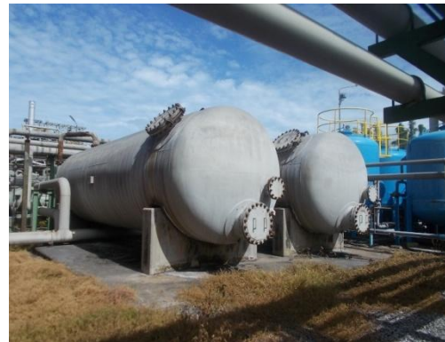
รูปที่ 3-15 Filtering System
