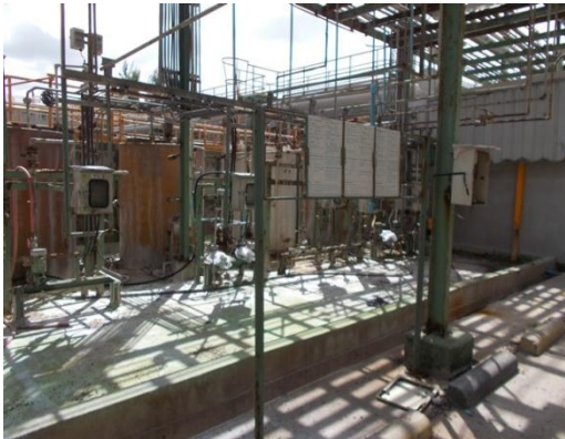
รูปที่ 3-12 pH Adjustment System
