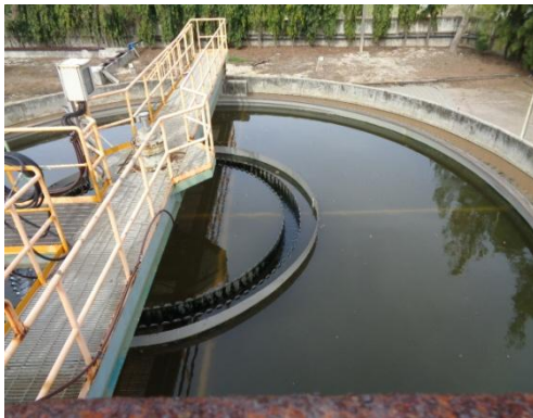
รูปที่ 3-14 Flocculation & Sedimentation
