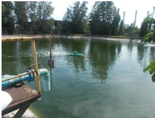
รูปที่ 3-22 Final Check Basin ขนาด 3,300 ลูกบาศก์เมตร
