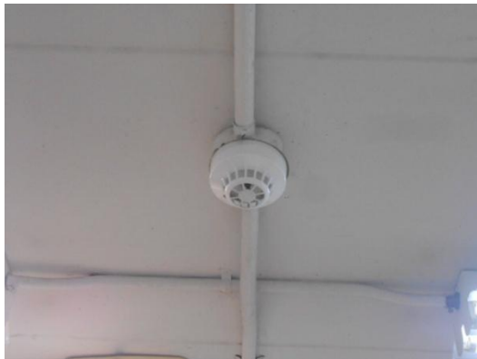
รูปที่ 3-39 Heat Detector
