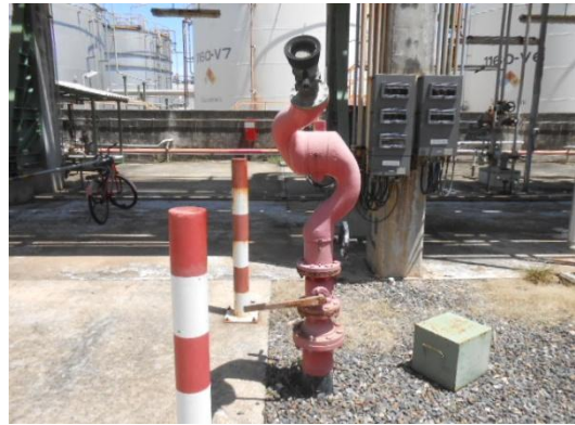
รูปที่ 3-46 Fixed Water Monitor
