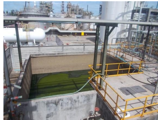
รูปที่ 3-19 Oily Sewer
