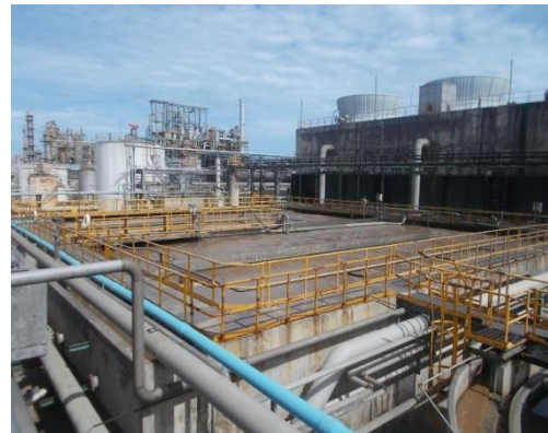
รูปที่ 3-13 Activated Sludge System
