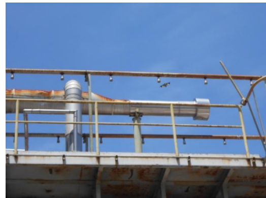
รูปที่ 3-50 Fixed Foam Spray System
