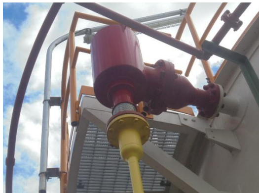
รูปที่ 3-49 Fixed Foam Discharge Outlet
