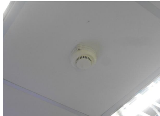
รูปที่ 3-40 Smoke Detector
