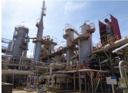
รูปที่ 3-6 Double-Contact/Double Absorption เพื่อบำบัด \text{SO}_2 และ Acid Mist
