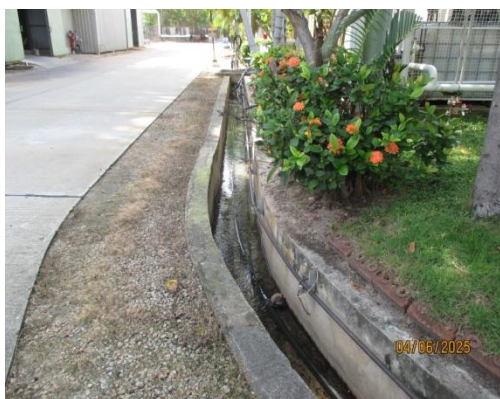
รูปที่ 3-10 รางระบายน้ำแบบเปิด
