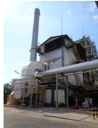
รูปที่ 3-9 อุปกรณ์บำบัดฝุ่น (Electrostatic Precipitator) จาก Boiler Type
